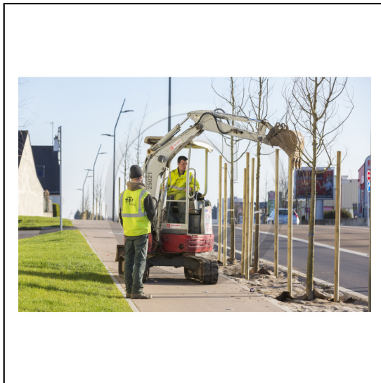
Plantation des arbres dans l'allée Raymond Queudet. Chantier Triskell_Lorient***Planting trees in the alley Raymond Queudet. Triskell_Lorient building site
