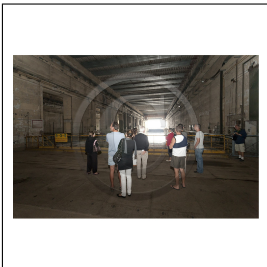
Lorient _ visite du bloc K3 de la base de sous-marins. Lorient _ visit of the block K3 base submarines.
