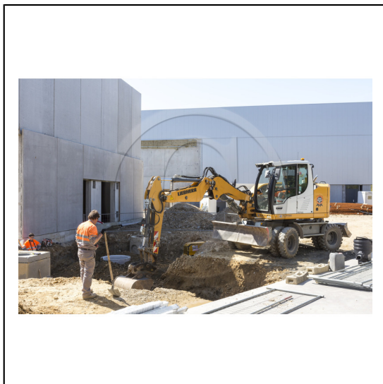
AVRIL 2018 _ Construction de la nouvelle caserne des pompier (Sdis) à Lorient _ Janvier 2018***AVRIL 2018 _ Construction of the new fire station (Sdis) in Lorient _ January 2018
