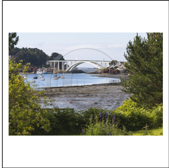
Le pont de Kerisper franchissant la rivière de crac'h et reliant la Trinité sur Mer à St Philibert.
